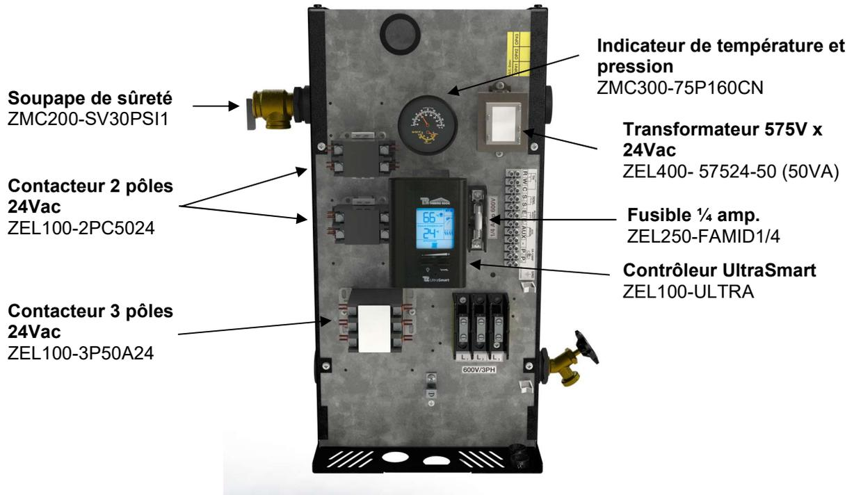
Figure 22 : Pièces de rechange BTH Ultra 600V-3 ph.
