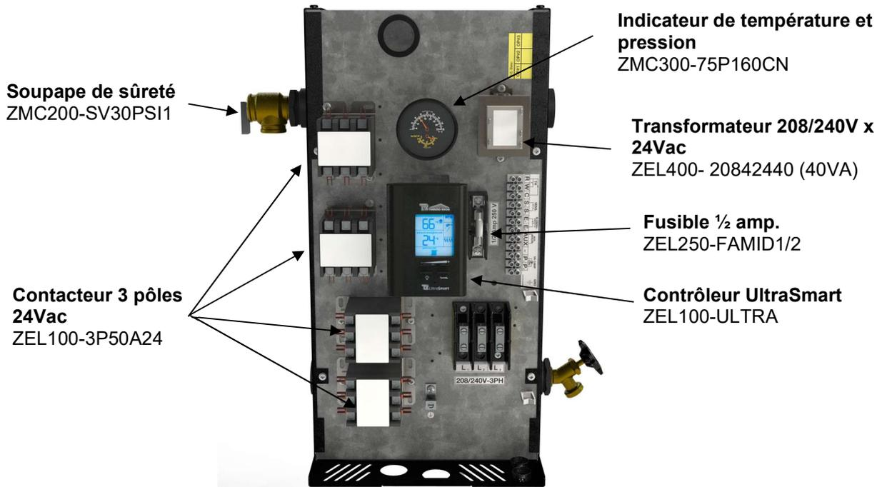
Figure 20 : Pièces de rechange BTH Ultra 208/240V-3 ph.
